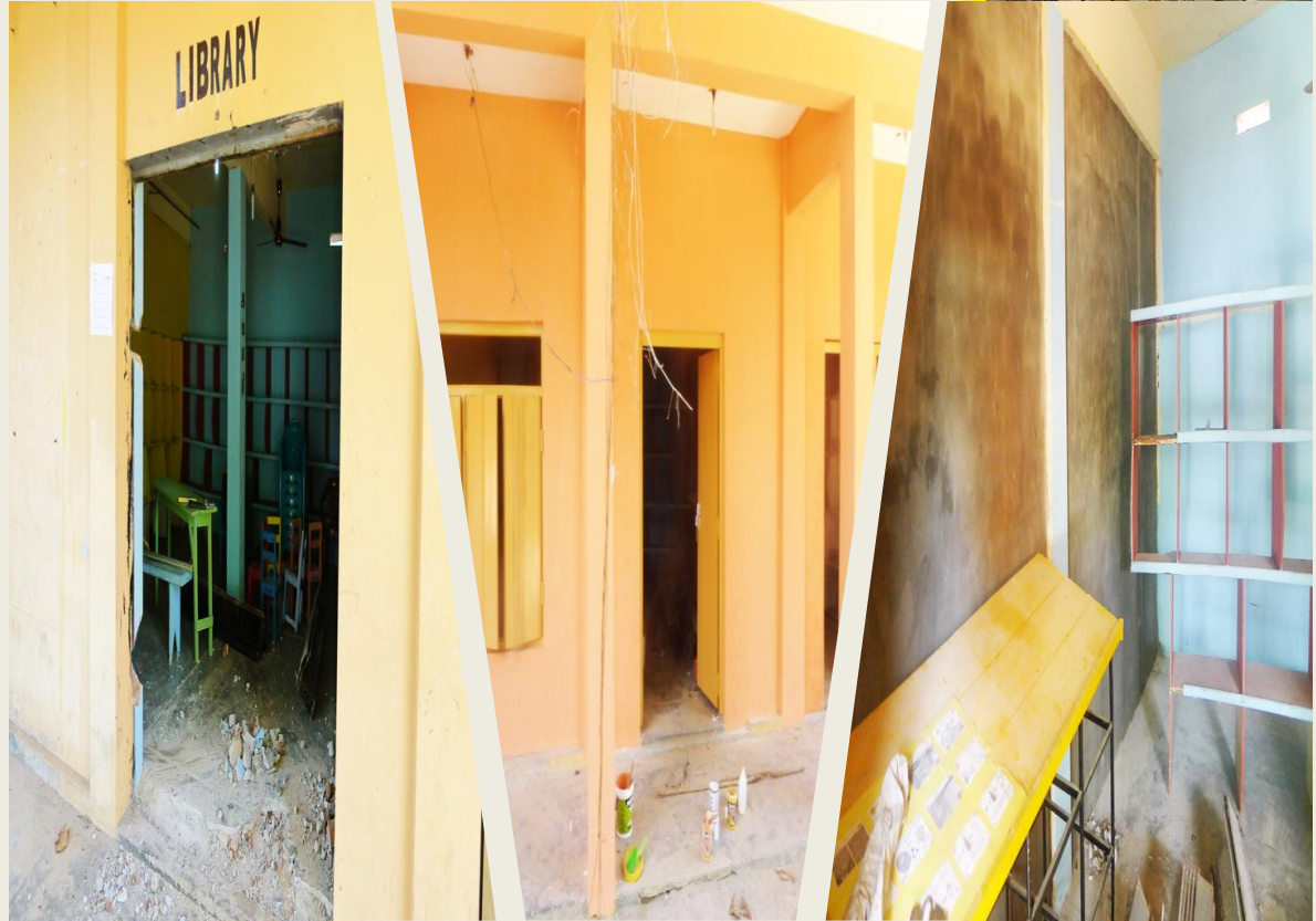
(왼) 불편한 문이 제거된 도서관모습 (가운데) 창문이 만들어지고 편리한 문으로 교체 (오) 가벽을 허물고 벽돌을 쌓았다
