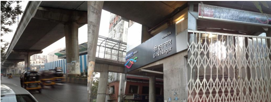
하루하루 개통이 다가오고 있음을 알려주는 D.N.Nager Metro역, 저 멀리 시범운영 중인 열차가 보인다. 역 근처에는 기타 건물이 한창 건설 중이다.
