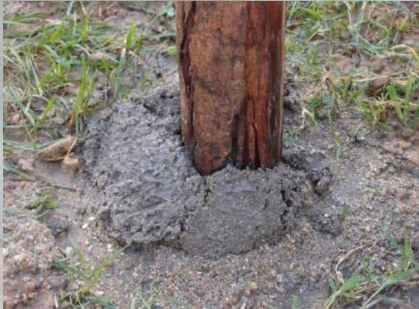
얼라 아저씨 집에서의 작업은 브은형 때와는 약간 다른 방법으로 진행되었다. 나무를 연결할 때 나무 끝 부분을 잘라서 못으로 연결했던 브은형 방식과는 달리 나무를 통째로 굵은 철사로 조인 후 못으로 박아서 연결하였다. 그리고 기둥을 세우는 구멍의 3분의 2정도를 흙으로 채운 후 나머지를 시멘트로 채웠다. 브은형 집에서는 시멘트를 사용하지 않았기 때문에 아띠들은 아띠들의 활동을 담당하는 썸남형에게 시멘트를 쓰는 이유를 물어보았다. 썸남형은 시멘트를 사용하는 이유는 폭우가 내렸을 때 시멘트가 쓸려나가지 않아서 기둥이 뒹비지 않기 때문이고, 또한 시멘트로 인해 땅 속에 있는 해충들이 나무를 갉아 먹는 것을 예방할 수 있기 때문이라고 설명해 주었다. 또한 브은형 집에도 시멘트 작업을 추가적으로 할 것이라는 언질을 주었다.
