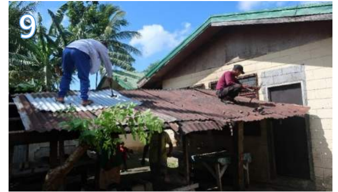
부역 철거 및 임시화덕 공사
