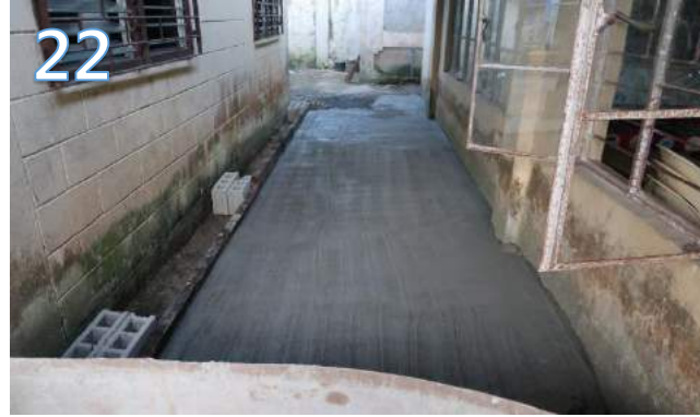
배수로 작업 우기 때마다 침수되던 부엌과 주변 길에 배수로 건설 & 시멘트 포장
