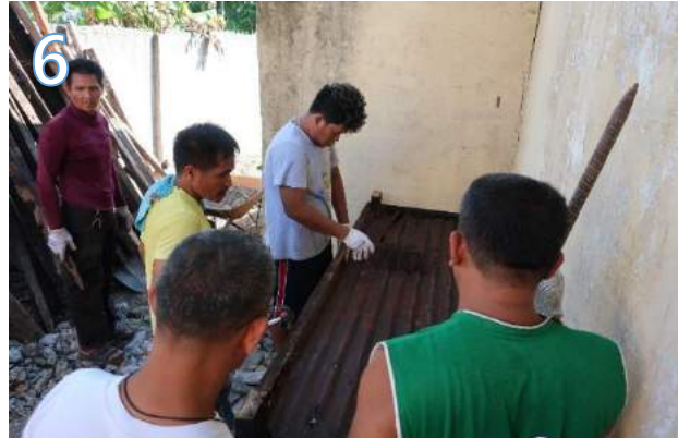
임시 화덕 공사
