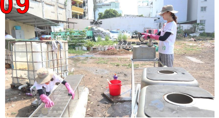
9. 중간벽 설치 및 중고 기자재 녹 제거
